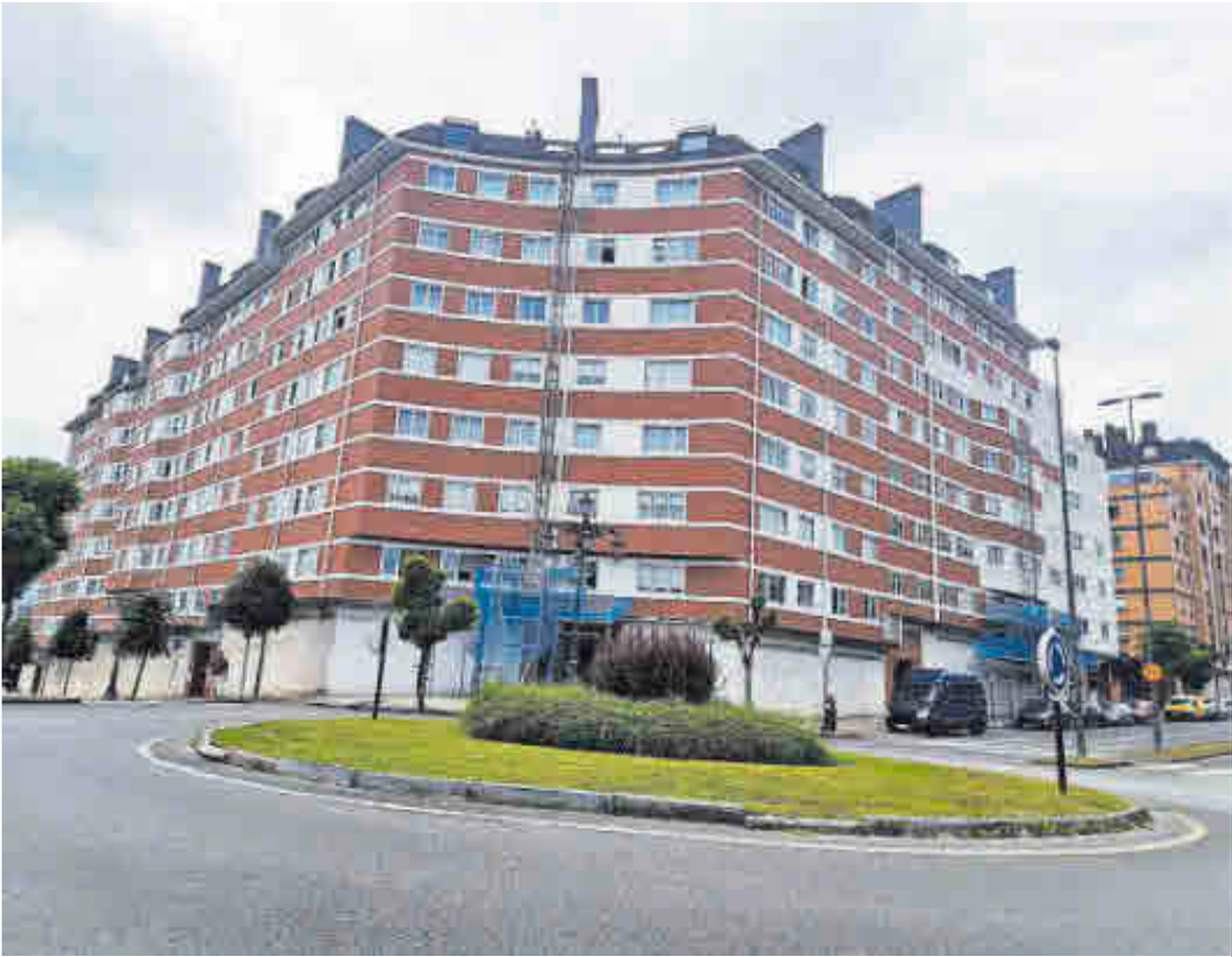
El edificio en cuyos bajos se instalará la nueva sede de Protección Civil.
